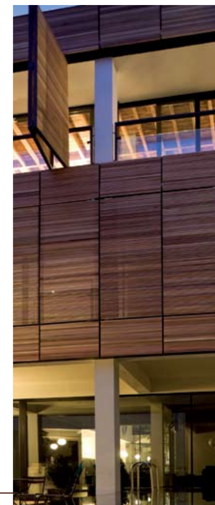
De twee gevels met bekleding in Western Red Cedar, waarachter telkens twee lofts, staan tegenover elkaar boven de binnenkoer met zwembad.
